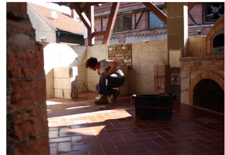
Der Boden wurde aufwändig mit Fliesen im Fischgratmuster belegt, um eine leicht zu reinigende Backstubenfläche zu garantieren. Aussen und innen wurden die Wände verputzt und mit weisser Lehmfarbe gestrichen.
